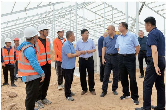
• 在铁发新村移民安置区建设现场调研
